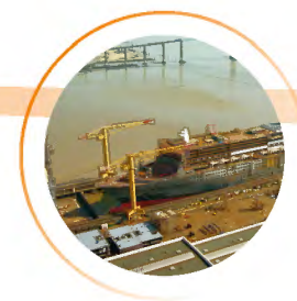
Grand port maritime de Nantes Saint-Nazaire ( photo : DREAL )
