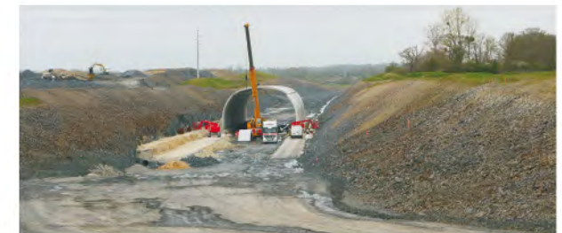
Travaux LGV Bretagne-Pays de la Loire ( photo : DREAL )
