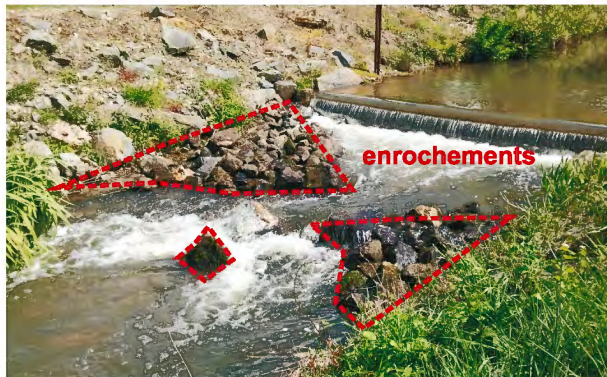
Amélioration de la continuité écologique sur une station d'hydrométrie grâce à la mise en place d'enrochements ( photo : DREAL )
