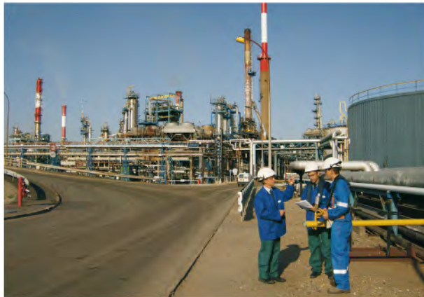
Visite d'inspection - Donges (44) (photo : DREAL)
