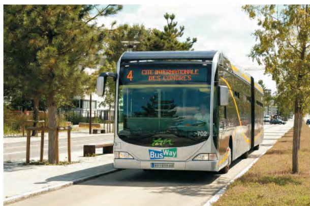
TAN, ligne du busway ( photo : DREAL )
