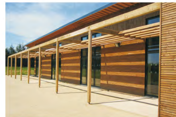
Salle polyvalente de Mouais (44), en terre crue, bois et bottes de paille.
